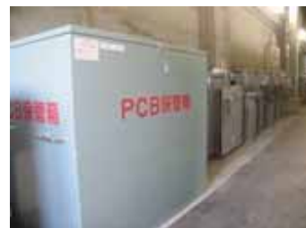
荒牧団地PCB保管状況 (2014.7撮影)
